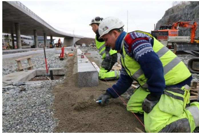
Kantstein legges av Steinar Endresen og Fredrik Holmedal
